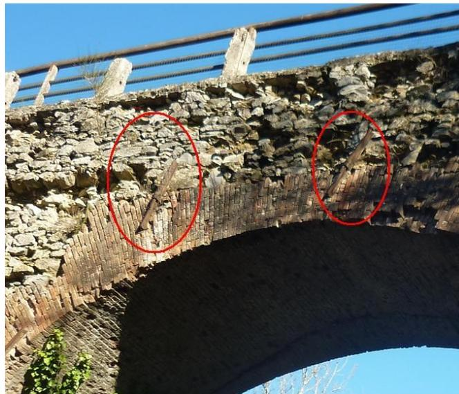
Fig. 1. Particolare del fornice stradale del ponte sul torrente Crevolone, con evidenziate le chiavi delle catene di consolidamento della struttura, realizzate con spezzoni di binari "Vignoles".
